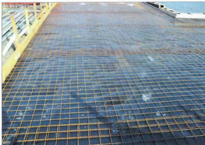
Figura 15. Detalhe da colocação geomembrana de Polietileno da alta densidade – PEAD.
