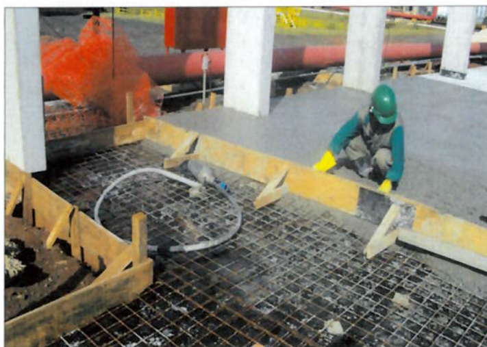
Figura 16. Detalhe da aplicação do concreto sobre a geomembrana de Polietileno da alta densidade – PEAD.
